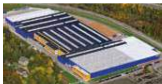
Hörmann KG Eckelhausen, Allemagne
